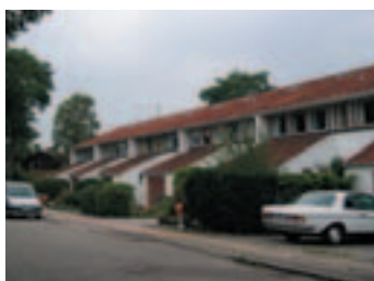
Rækkehusene ved Kildevænget.
