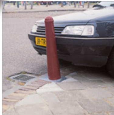
Straks efter påkørsel rejser den fjedrende Amsterdam stele sig ved egen hjælp
